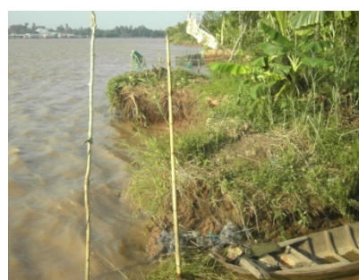
Hình 2. Xói lở đầu cù lao Chải thành phố Cao Lãnh
