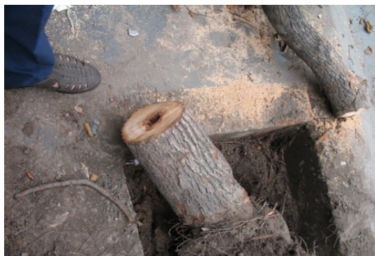
(a) Đoạn gốc cây Long nã bị mối tấn công ở giữa lõi gỗ
