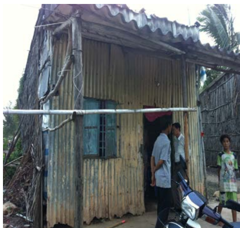
Hình 8. Nhà hộ nghèo phường Nhà Mát
